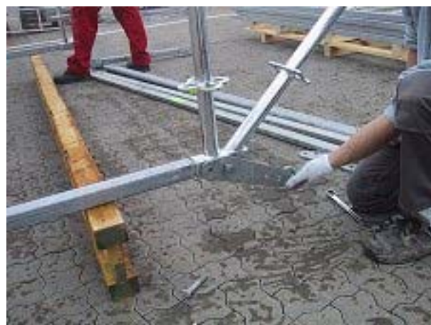
Der monteres kipsamler på kipelementet, her bruges M 90x16 bolte.
