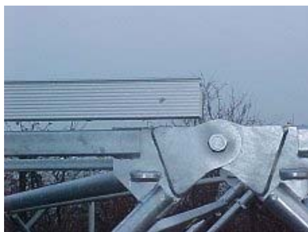
Skinnen stødes op mod kipelement og spændes først til, når det samlede tagelement bliver kranet op i korrekt vinkel.
