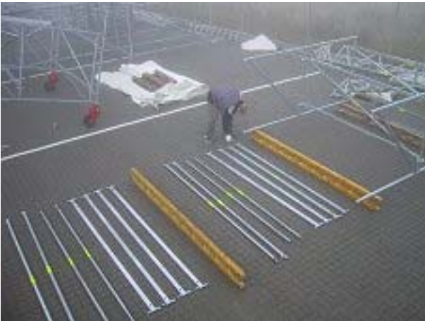
2 tagelementer stilles oprejst med 3 m. mellemrum (tagelementer skal vendes rigtig jf. billede).
