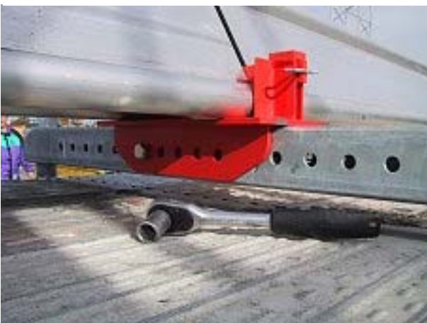
Herefter monteres skinneholderens låsesystem, samt split.
