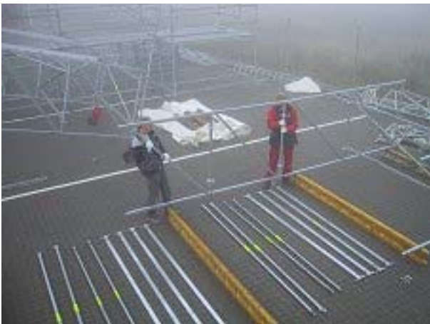
Tagelementerne skubbes sammen.
