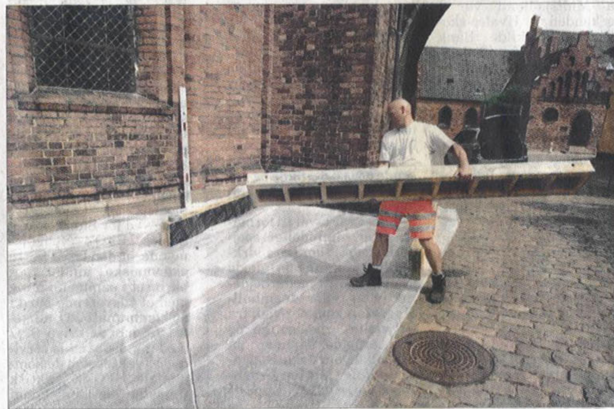
Thomas Behr startede i går så småt arbejdet med at overdække korsskæringen på Roskilde Domkirke.
