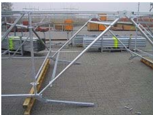
De to kipelementer samles i toppen med en M 24x60 bolt.
