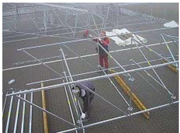
Der monteres horisontale diagonaler UBH 300/150 og 2 rørdiagonaler UBL 300/100
