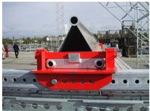
Når alle alurulleskinner er monteret, slutes af med endestop, samt skinneholders låsesystem og split.
