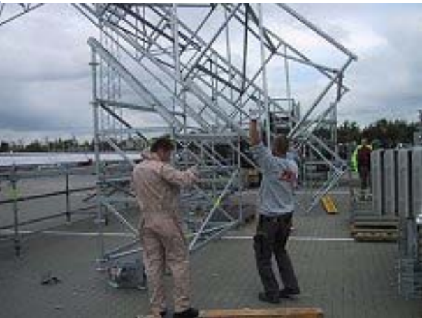
Det komplette endevederlag skubbes på plads under det komplette tagelement.
