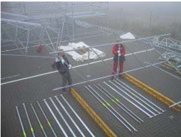
Tagelementerne skubbes sammen.
