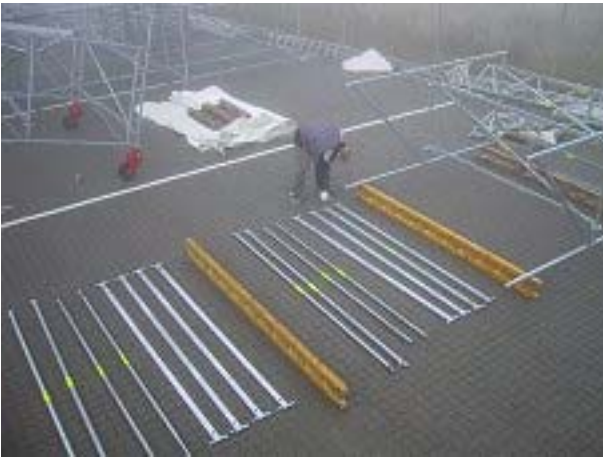
2 tagelementer stilles oprejst med 3 m. mellemrum (tagelementer skal vendes rigtig jf. billede).
