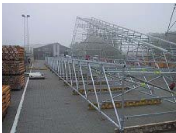
Når hele tagelementet er færdigsamlet køres det til montagedstedet.
