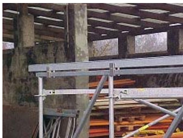
De monteres med 1,5 m. mellemrum, herefter ilægges teltskinnen.
