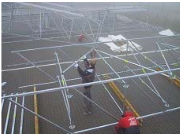
Der monteres horisontaldiagonaler.
