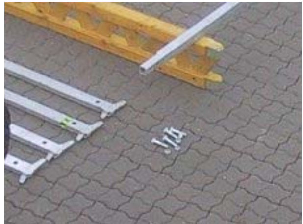
Der skal bruges M16x70 bolte til samling af tagelementerne.
