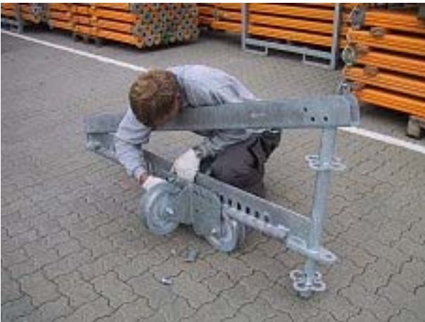
Løbeværk monteres på endevederlag.
