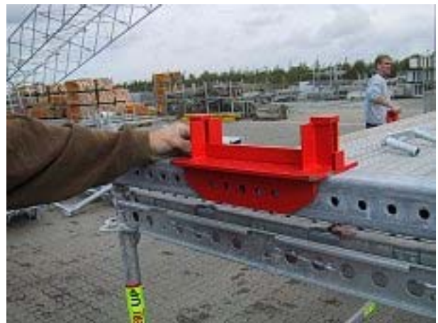
Skinneholder monteres, der bruges 1 M 16x120 bolt.
