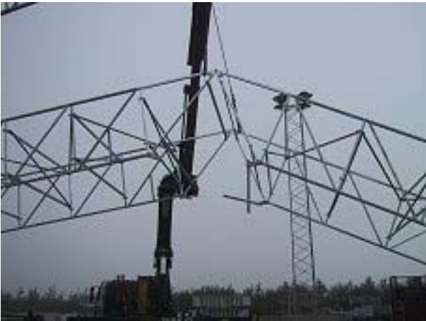
Afstivningsrøret demonteres og tagelementet løftes op til korrekt vinkel.
